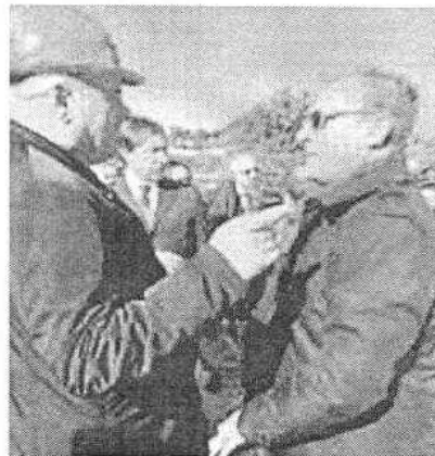
Rosario Faraci (a destra), presidente del Consorzio autostrade siciliane, con il deputato regionale Giuseppe Gennuso sul cantiere dell'autostrada. Al centro, Nitto Rosso.
